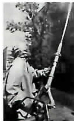
集合住宅の放水除染作業の様子
