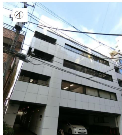
④鳥居をくぐったら15メートル進んだ機山館の隣の隣のビルが「いろは本郷ビル」
